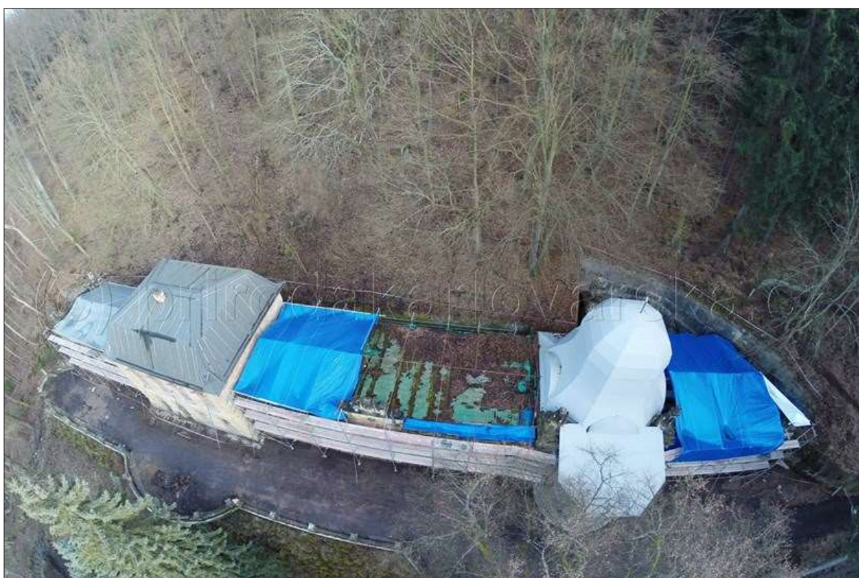
pavilon Ottova pramene, plnárna, kolonáda, lázeňský dům, horní dojezdová stanice
