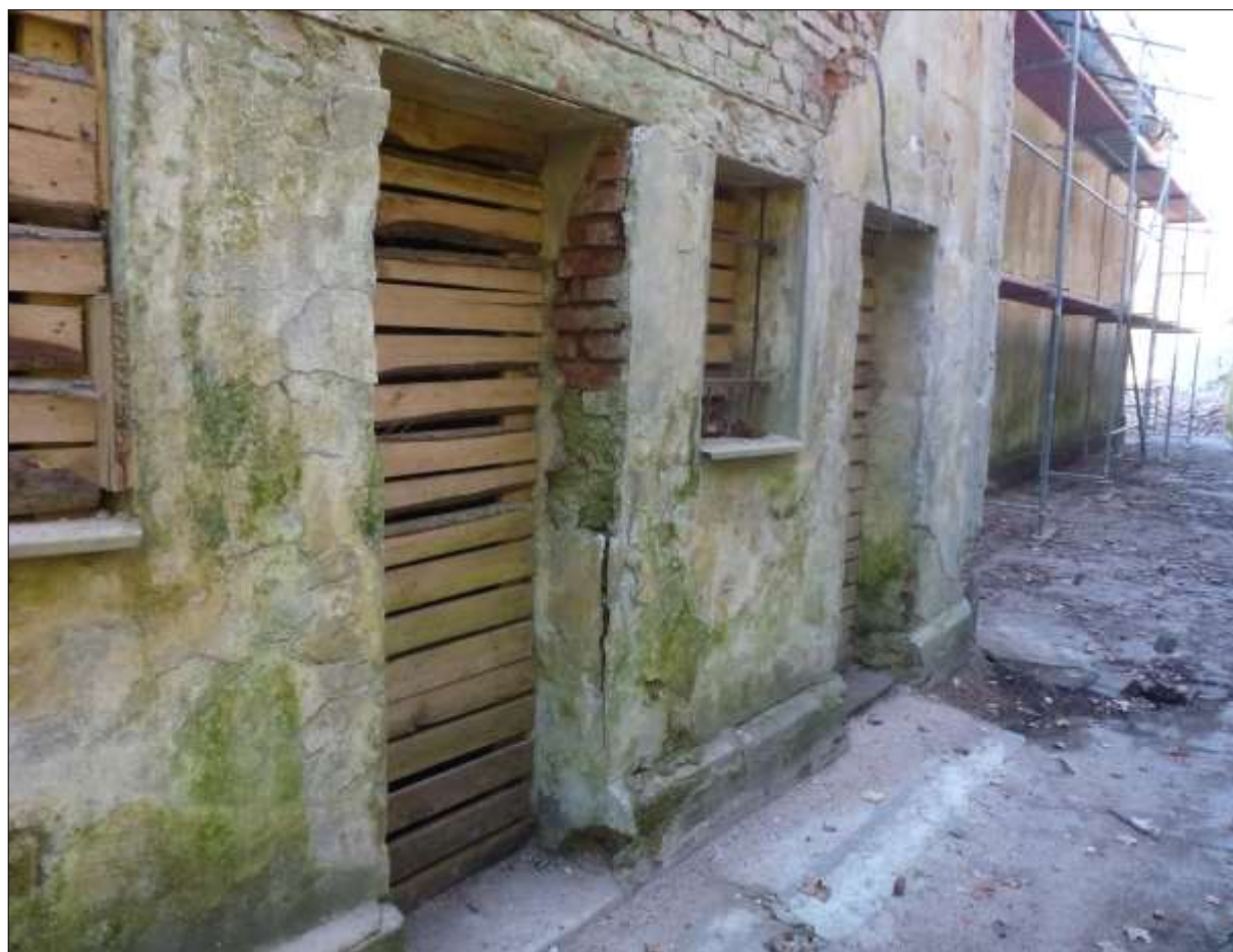
kolonáda, lázeňský dům, horní dojezdová stanice
