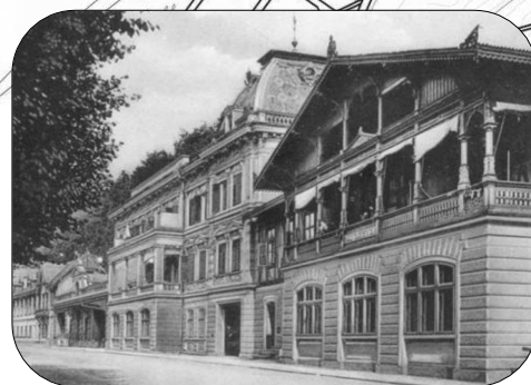
budova č. 5 – Švýcarský dvůr čp. 37 budova č. 6 – Vila Vilemína čp. 47 budova č. 8 – Expedice čp. 52
