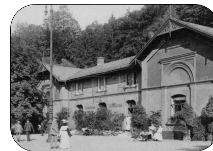
budova č. 2 – restaurace čp. 75
